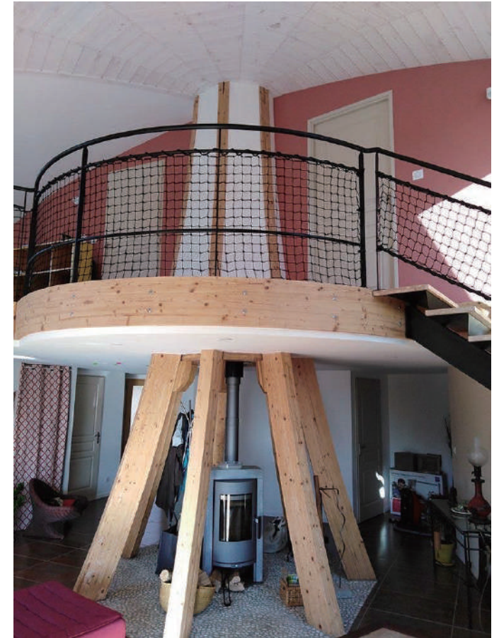
アイアン手すりで金具は取付けられないので、 テンションロープで取付けた例
