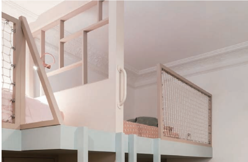
フレームと金具を設置し取付けた例
